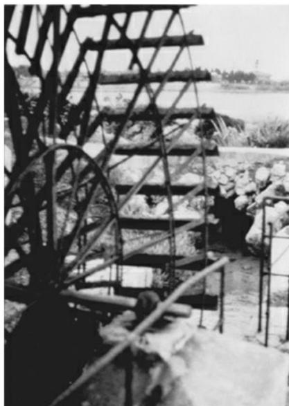
图 1.10. 塞伯罗尼亚岛上的水车，建在泄水道上，用流入的水发电。当水位到达水车时，水位下降到海平面以下 2 米左右，然后再下降几米，然后进入裂缝。(作者摄影)
